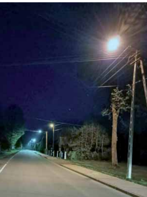
Wymiana oświetlenia ulicznego
