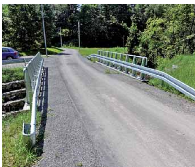
Droga i przepust w Malinówce
